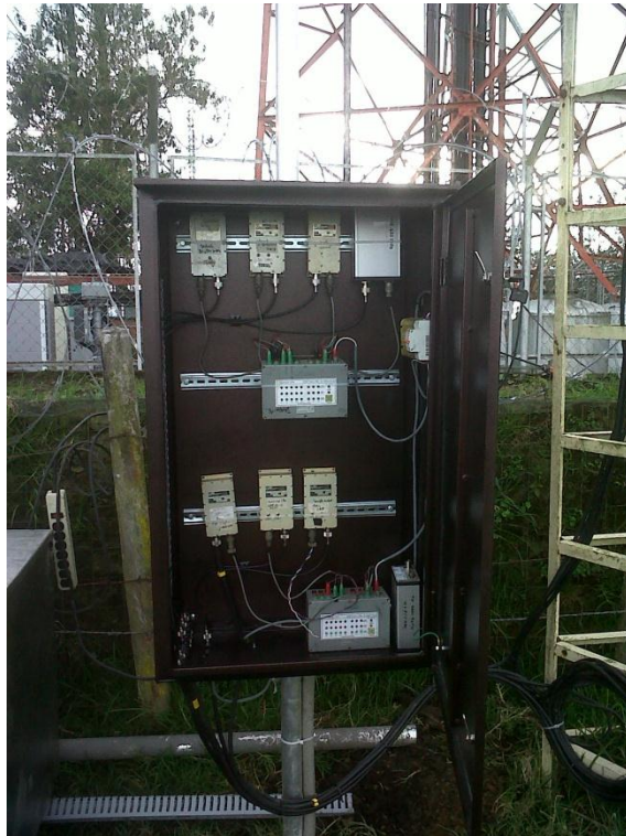
Figura 57. Instalación de los gabinetes en CIELO ROTO.
