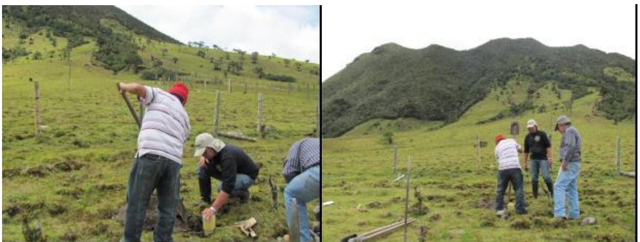
Figura 93. Instalación de estaciones de Gas Radón en el Volcán Cerro Bravo. Segundo Semestre de 2011.
