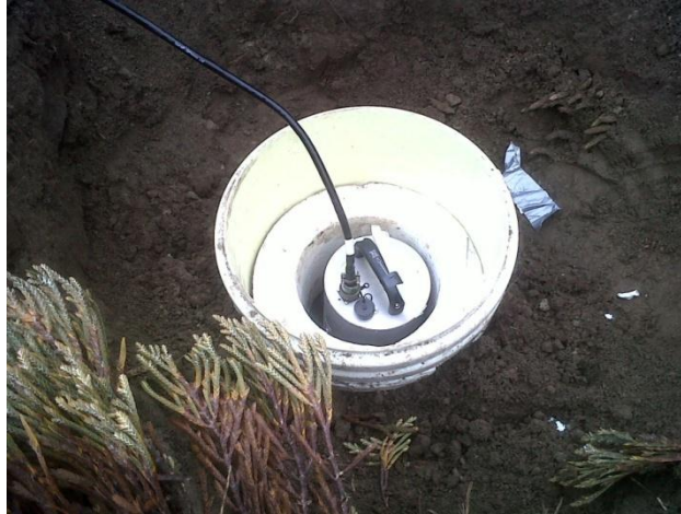
Figura 46. Instalación del sensor de Banda Ancha en la estación de Esmeralda.
