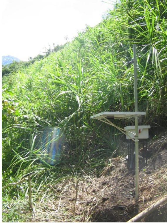
Figura 56. Instalación de la estación de temperatura ESTATUAS.
