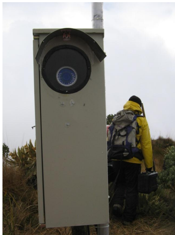
Figura 2. Instalación de la Cámara Web PIRAÑA.
