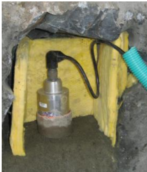
Figura 107. Mejoramiento del emplazamiento del sensor estación MARSELLA.
